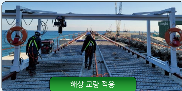
전용대차를 이용한 설치
