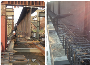
9 하부케이싱, 철근, 쉬스, 정착구 설치
