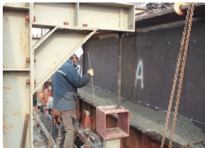
10 거푸집 조립 및 콘크리트 타설
