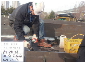
5 지조립 용접부 비파괴 검사
