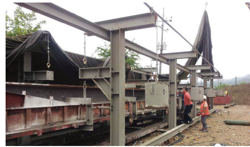
케이싱 콘크리트 무응력 지지시스템
