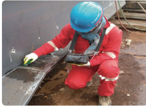
2 I 거더 용접부 비파괴 검사
