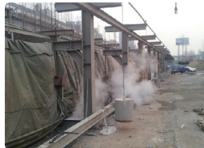
11 콘크리트 증기 양생
