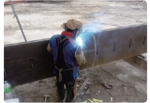
4 I 거더 지조립 현장 용접
