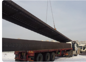
3 I 거더 현장 반입
