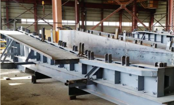
1. SS 부벽식 옹벽 공장 제작
