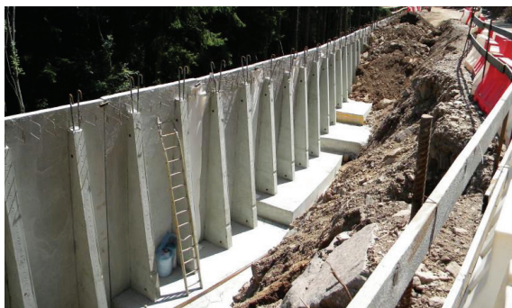
6. 기초 콘크리트 타설
