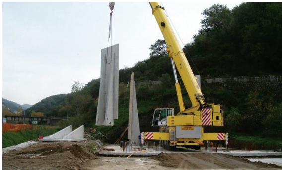
4. SS 부벽식 옹벽 가설
