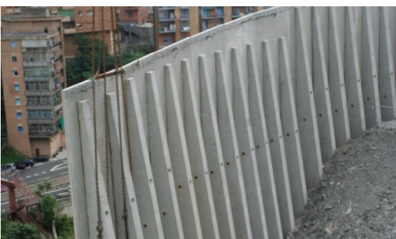
7. SS 부벽식 옹벽 뒷채움
