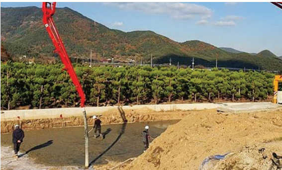
3. 현장 터파기 및 버림 콘크리트 타설
