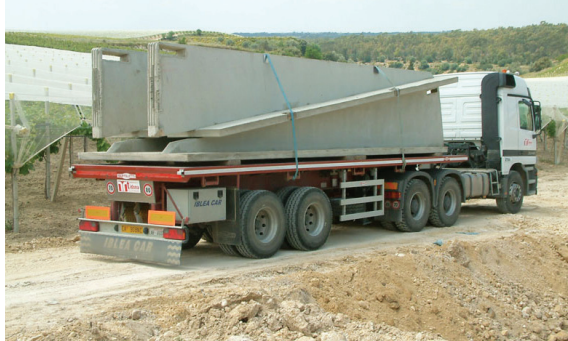
2. SS 부벽식 옹벽 운반
